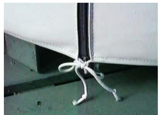
3. A continuación iremos palpando por el aislamiento hasta encontrar una toma. Se recomienda usar la noticia técnica como guía de la ubicación de todas las conexiones. Una vez localicemos una, mediante una maza golpeamos el aislamiento contra la conexión para que está quede marcada en el forro.
