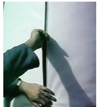
2. Atamos el cordel inferior del aislamiento y nos aseguramos que más o menos esté situado en el centro de la circunferencia Y comprobamos que el aislamiento esté repartido de una manera homogénea a lo largo del perímetro del acumulador.
