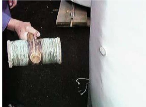
4. Una vez tenemos marcada la conexión, mediante un "cutter" realizamos un corte en el forro que se adapte a la misma y retiraremos el material sobrante.
